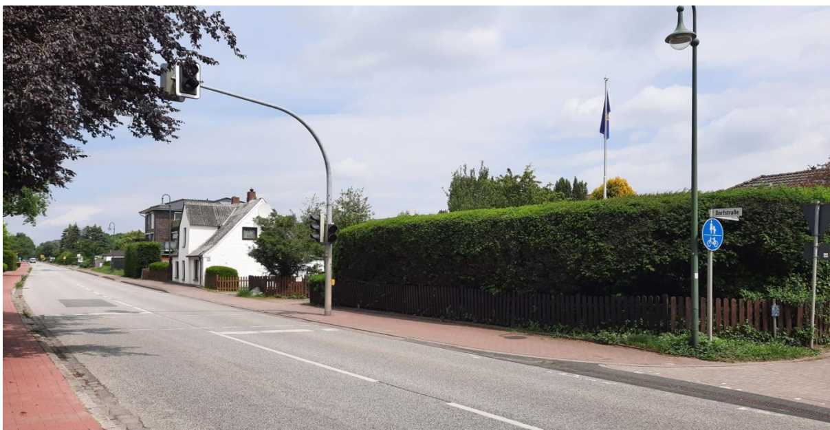
Abbildung 20: Fußgängerampel am Neubaugebiet Achtern Hollernbusch
